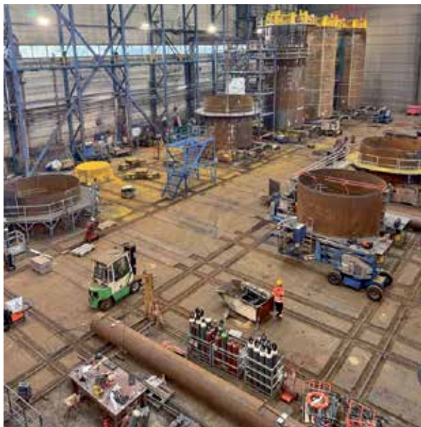
HØYT TEMPO: Oversiktsbilde fra verkstedhallen i Kirkenes der nye CAP X-strukturer er under bygging. Foto: Kimek AS
